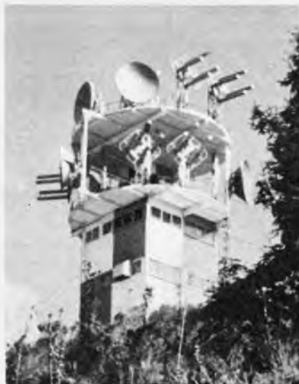
Fernmeldeturm Las Palmas (3200 m über dem Meeresspiegel), die erste Relaisstelle nach Mexiko City. Der Turm trägt bereits Antennen für ältere 2-GHz- und 4-GHz-Systeme; er rourde mit Anlagen des 6-GHz-Systems FM 1800/TV-6000 von Standard Elektrik Lorenz AG bestückt (Aufnahme: A. Müller)
