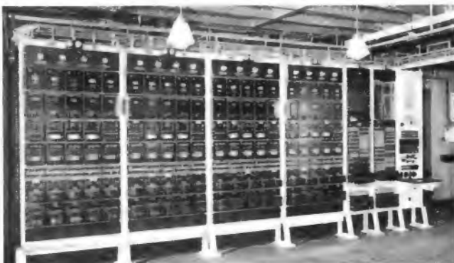
Bild 1. Tonleitungs-Verstärkereinrichtungen nach dem Entwicklungsstand von 1929 (ehemalige Tonleitungsstelle Berlin)
