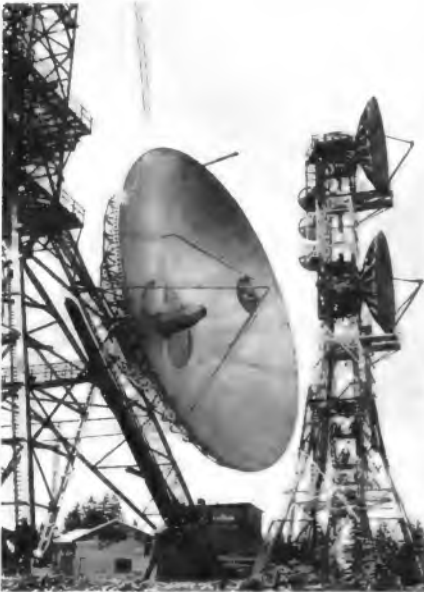
Montage des 10-t-Cassegrain-Richtfunkspiegels auf dem Torfhaus im Oberharz für eine neue 2-GHz-Richtfunkstrecke nach Berlin
