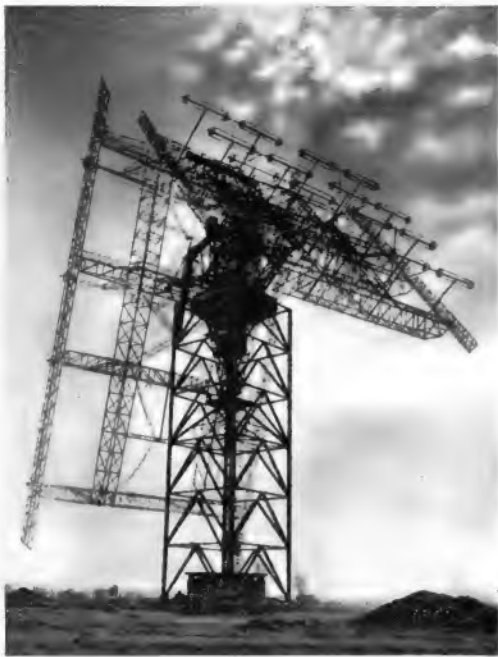
Bild 3. Horizontal und vertikal bewegliche Drehstandantenne vom VEB Funkwerk Köpenick mit einem Trägermast (Foto: H. Blunck/ Radio und Fernsehen)
