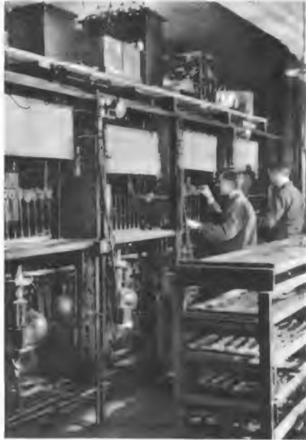
Bild 1. In den Anfangsjahren der Röhrenfertigung wurden die Röhren noch einzeln gepumpt, abgeschmolzen und getettert
