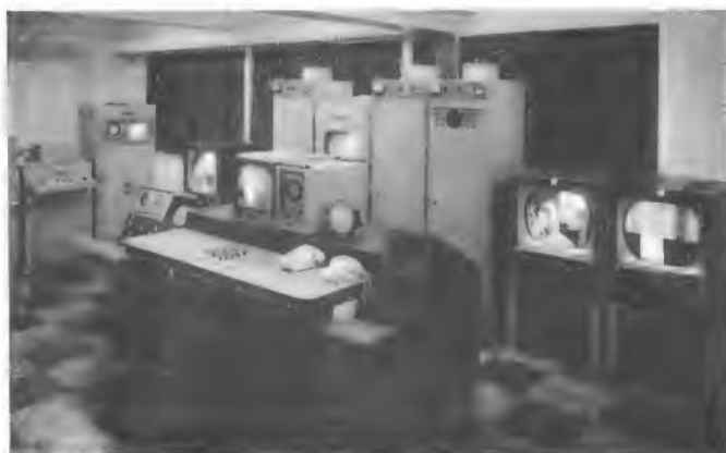
Bild 4. Blick auf Kontrolltisch und Bedienungspulte, Coder- und Testgeneratorschrank sowie Farbmonitore im Zentralgeräteraum
