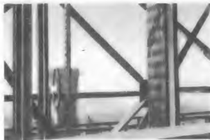
Bild 2. Förderkorb mit ringförmigem Koppelrahmen am Förderseil. Die Führung des Korbes besteht aus Eisen-schienen
