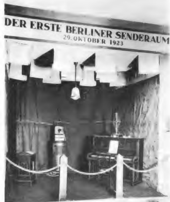
Bild 4. Nachbildung des ersten Senderraumes im 5. Stock des Voxhauses mit primitiver Dämpfung, anfangs aus Krepppapier, später aus Scheuertüchern. Hinter der Wolldeckenrückwand befand sich die Technik mit dem Mikrofonverstärker
