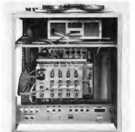
Bild 2. Rückansicht mit Anschlußfeldern und Verstärkern
