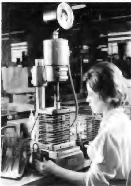
Bild 3. Zusammenbau von Scheibenzellen zu Siliziumgleichrichtersäulen. Der Anpaßdruck wird gemessen und konstantgehalten
