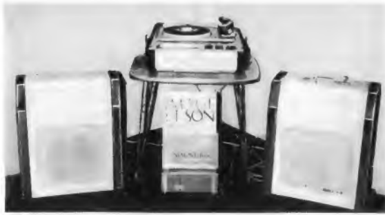
Bild 7. Typischer französischer Stereo-Phonokoffer mit zwei getrennten Lautsprechern. Die Lautsprecherboxen können zum Transport zusammengestellt werden, Schnappverschlüsse halten die Gehäuse wie ein Koffer zusammen (Image & Son)
