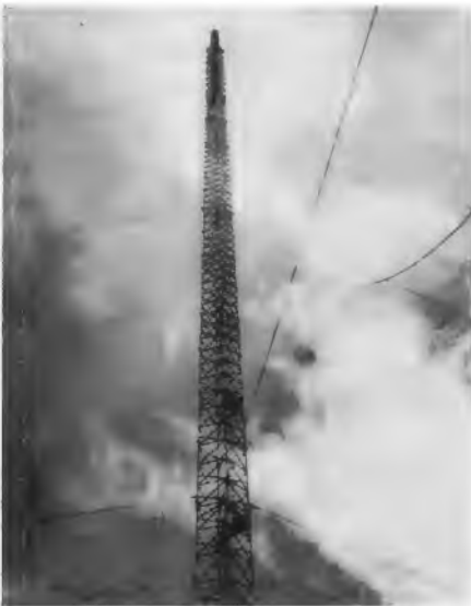
Bild 6. 200-m-Mast der Station Alverstone
