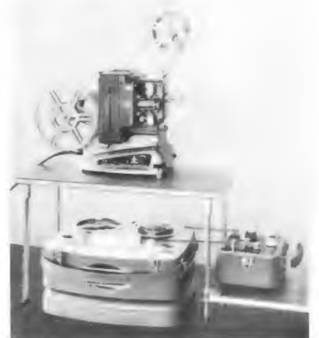
Bild 2. Bolex-Projektor M 8 R mit Synchronizer und Tonbandgerät in der zur Tonaufnahme und -wiedergabe erforderlichen Stellung
