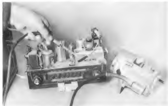
Kompressor-Gebläse Sprayit 409 mit handlichem Druckluftschlauch beim Ausblasen eines Rundfunkempfängers
