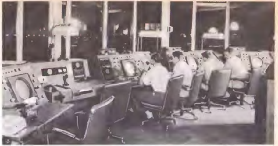
Bild 2. Radarkantrallraum auf dem Rhein/Main-Flughafen bei Frankfurt a. M. mit den Schirmen der GCA-Anlagen (Ground Controlled Approach = vom Boden gesteuerter Anflug)
