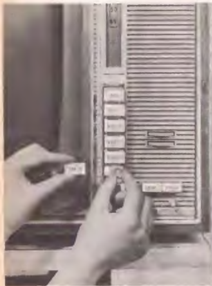
Bild 3. Bedienfeld des FE 242 mit Programm-Wählautomatik (je drei VHF- und UHF-Stationen). Die Abtastspindeln für das einmahlige Belegen jeder Taste sind in die Tasten selbst eingelassen und nach Abzug eines Schiebers zugänglich
