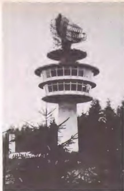
Mittelbereichs-Radaranlage auf der Neunkirchner Höhe im Odenwald mit der 14,5 m breiten und 7 m hohen Antenne (Reichweite: 120 nautische Meilen = rund 220 km mit einer Höhenbedeckung von 60 000 Fuß = rund 18 km; siehe auch den Aufsatz auf Seite 217 ff.)
