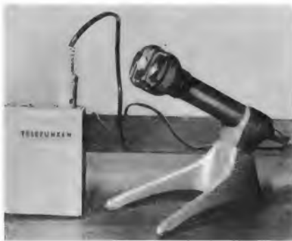
Bild 1. Taschensender zum Microport-junior für f = 37,1 MHz mit Mikrofon D 19 B
