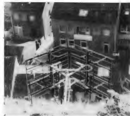
Bild 3. Die aus zwei Feldern bestehende Sendeantenne des Umsetzers für das Unterland (Kanal 8) ist an der Steilkante des Oberlandes verankert
