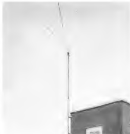
Bild 4. Die Sendeantenne am Turm des Verwaltungsgebaudes
