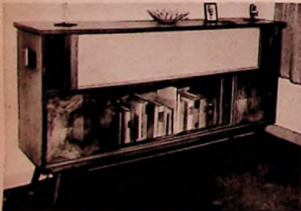
Bild 1. Vitrine mit eingebautem Schallumweg-Lautsprecher nach FUNKSCHAU-Bauvorschriften
