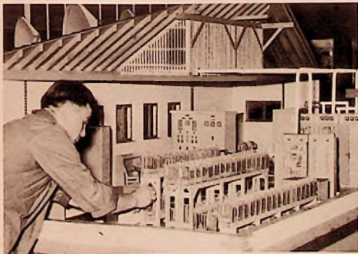
Bild 3. Teilansicht des Modells der eigentlichen Funkstation mit den nachgebildeten Batterien in Plexiglasgefäßen
