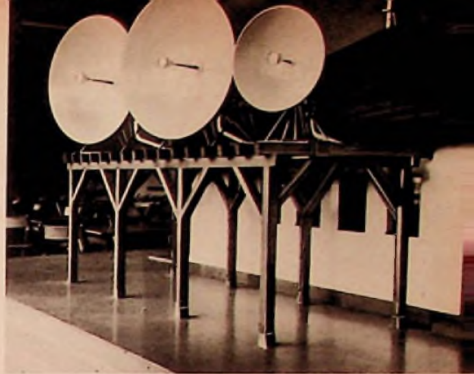
Bild 1. Das südliche Antennenpodest der Modellanlage mit den Metallmodellen der Parabolantennen (links und Mitte: Freda und PPM in Richtung Flockertshöhe/Feldberg, rechts: Freda in Richtung Koblenz)
