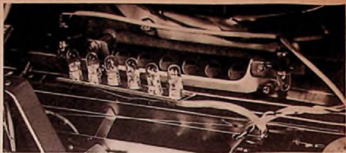
Bild 3. Leuchtkulisse des Klangmixers mit abgenommener Lampenleiste
