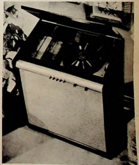
Bild 9. Hi-Fi-Anlage mit 12-Watt-Verstärker und vier Lautsprechern, Type „Gaité Parisienne“ von Capehart, mit Klangregistrier
