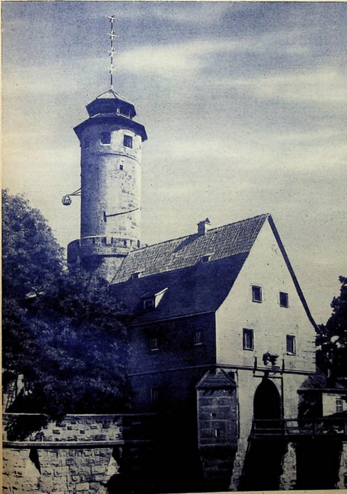
Der UKW-Sender Bamberg des Bayerischen Rundfunks, der mit 1 kW Leistung auf 87,7 MHz das Münchener UKW-Programm überträgt, bietet ein gutes Beispiel für die vorbildliche architektonische Eingliederung der Sendeinrichtungen in den Baustil der ehrwürdigen Altenburg.
