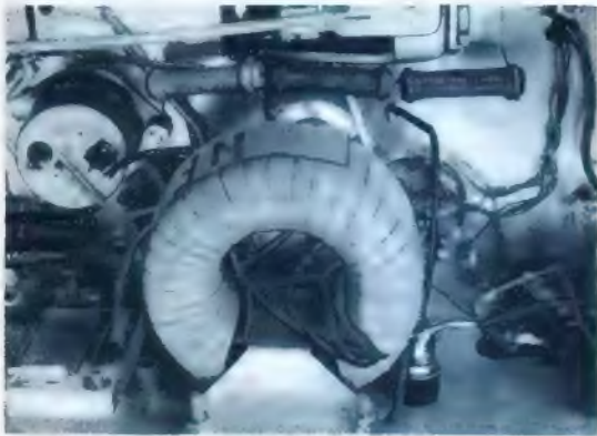
Der eingebaute Ringtrafo. Seine Befestigung geschieht mit Hilfe eines kräftigen Blechstreifens.
