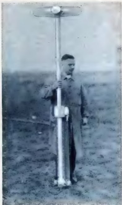
Dieses merkwürdige Ding ist ein Empfänger für Dezimeterwellen. Das Zubehör (der Mast und die Abschirmung hinter der Dipol-Antenne) ist größer als der ganze Empfänger, der in der runden Boxe oben sitzt.
