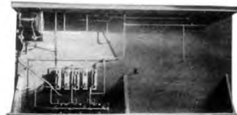
Ein Blick unter das Gerät zeigt die liegend montierte Drossel und die Überbrückungsblocks.
