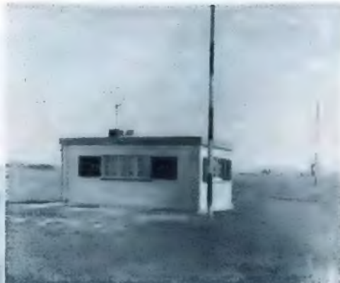
Auf dem Dach der Bodenfunkstelle der Peilrahmen.
