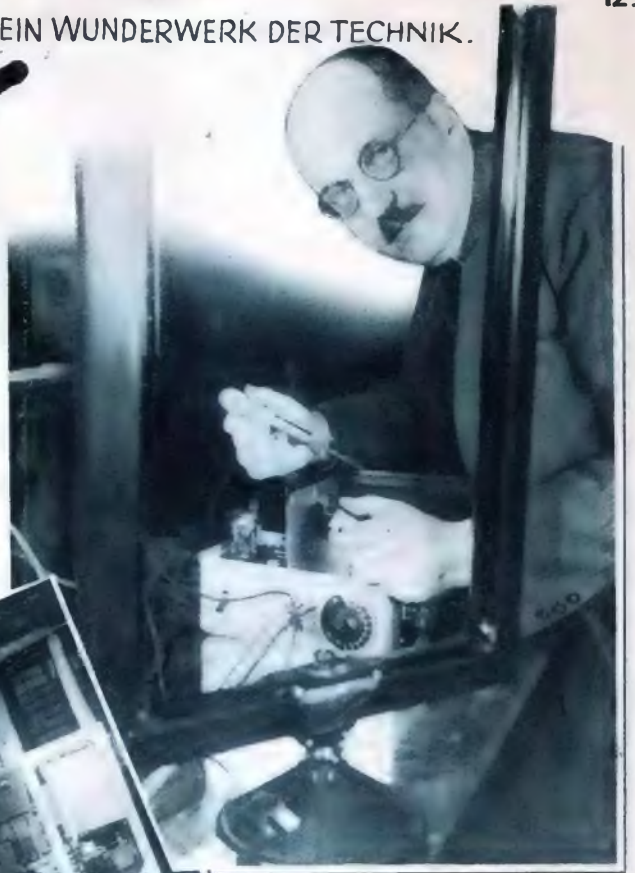
Dr. Reißer mit seinem neu konstruierten Zusatzgerät für höchste Abstimmshärte und Rahmempfang.
