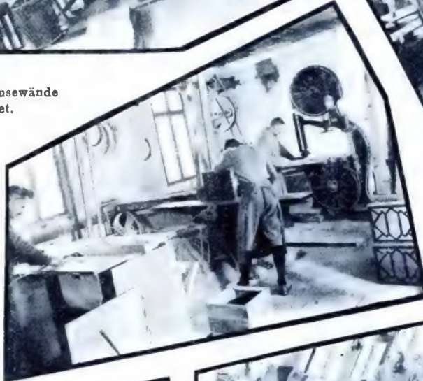
Abb. 4. Nacharbeitung der Gehäuse.
