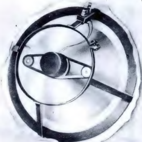
Blick auf den Konus von hinten mit Triebspule und Geradföhrung.
