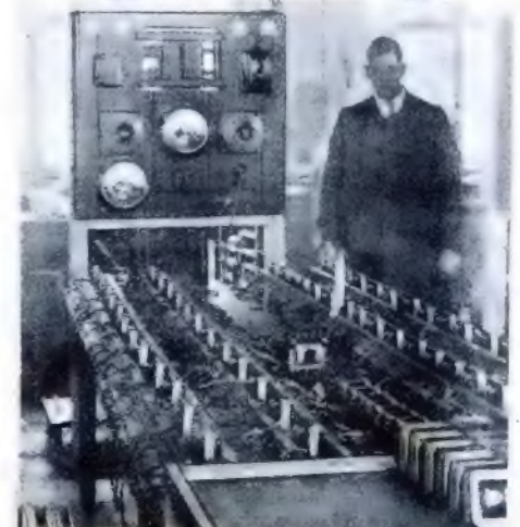
Isolationsprüfung mit hoher Spannung.
