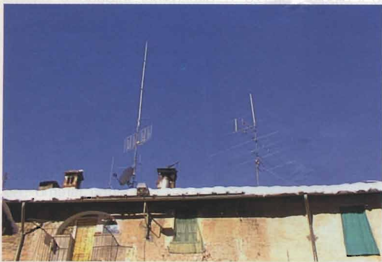
Antenne sul tetto in sistemazione rurale, era il weekend di un capodanno.
