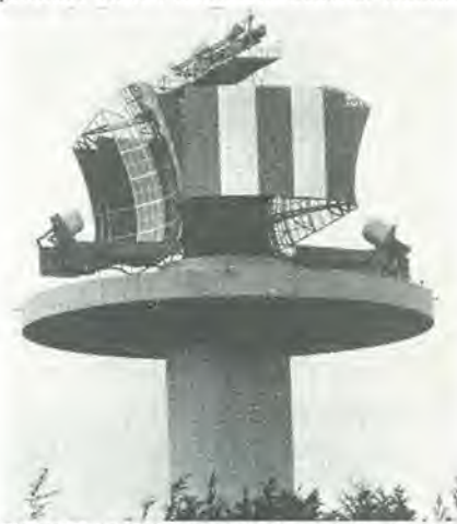
Figura 7. La sicurezza del volo a lungo raggio è garantita da torri radar analoghe a questa. Esse si trovano distribuite sul territorio e garantiscono la sicurezza nell'intero spazio aereo ed a tutte le altezze.
