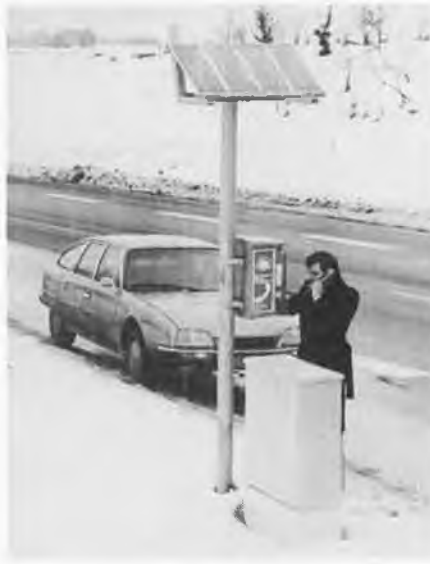
Photo 4. Heureusement que le soleil brille pour tout le monde. Téléphone de campagne alimenté par une batterie de capteurs solaires.
