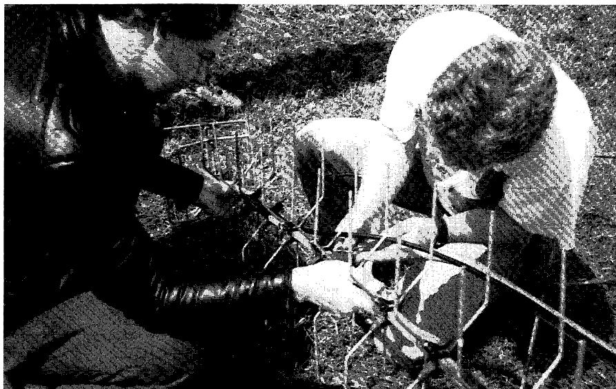
Freek, PE1RDD en Remko, PE1MEW, herstellen de geknakte 70 cm antenne.
