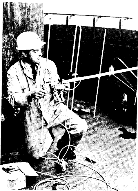
Wim Kamp, PAoWJK, bezig met de montage van ontvang-antennes op 150 meter hoogte; de antenne wordt daarna gemonteerd op de rand van het bordes welke op de achtergrond zichtbaar is.
