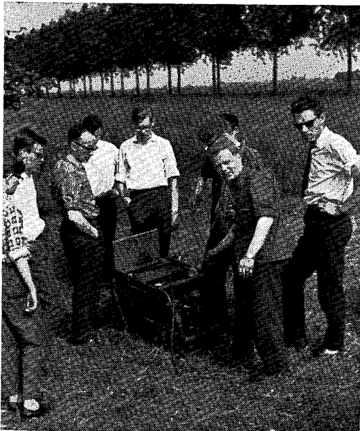
De door Radio Van Santen beschikbaar gestelde benzine-generator leverde enkele puzzles op, zodat de transformator die de spanning naar 220 V moest brengen heet gestookt werd. Hierbij een opname van het moment waarop de afdeling Rotterdam tijdens de veldagvoorbereidingen op 8 Juni deze tegenslag te incasseren kreeg. (Foto: PAoKQ)
