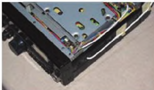
Foto F: El coaxial de FI se coloca a lo largo del chasis y se pasa por un agujero preexistente. El cable finaliza en un conector BNC macho.
