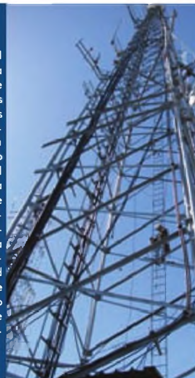
Foto 4. Cuando trepo a una torreta, es importante ascender con seguridad y eficiencia, puesto que debo reservar parte de mis energías para realizar el trabajo en la cima de la torreta y el descenso posterior, cuando haya terminado el trabajo.
