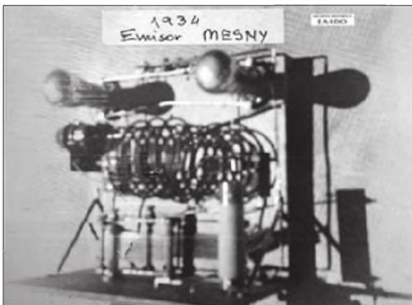
Foto C. Vista del transmisor con circuito Mesny que montó José Buján para su estación de 1934. Lamentablemente, la escasa calidad de la foto no permite apreciar los detalles del montaje.
