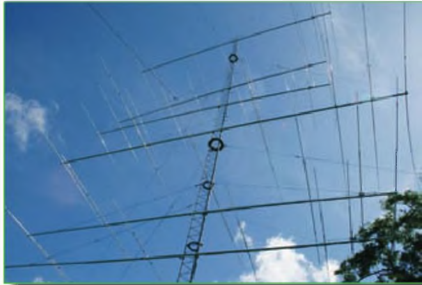
Torre de 31 metros con los stacks (6/6 Yagi) para 10, 15 y 20 metros.
