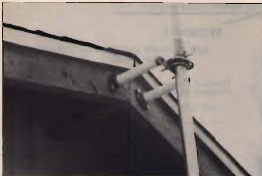
foto 4 Distanziatori isolanti per il fissaggio al tetto.
