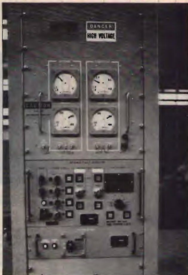
Il pannello di controllo dell'antenna e il rilevatore di guasti.
