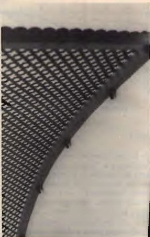
foto 3 La lamiera traforata di alluminio va fermata ai trafilati di sostegno con una serie di viti e dadi da 3 MA.
