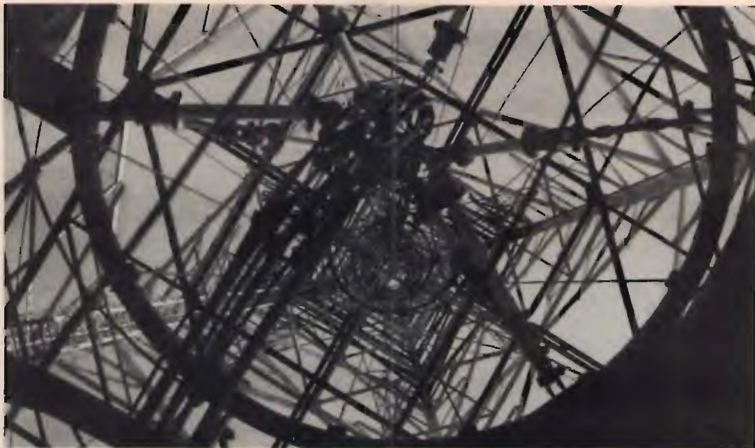
Figura 3 L'intelaiatura di una delle quattro torri vista dal basso. Al centro sale la linea coassiale RF.
