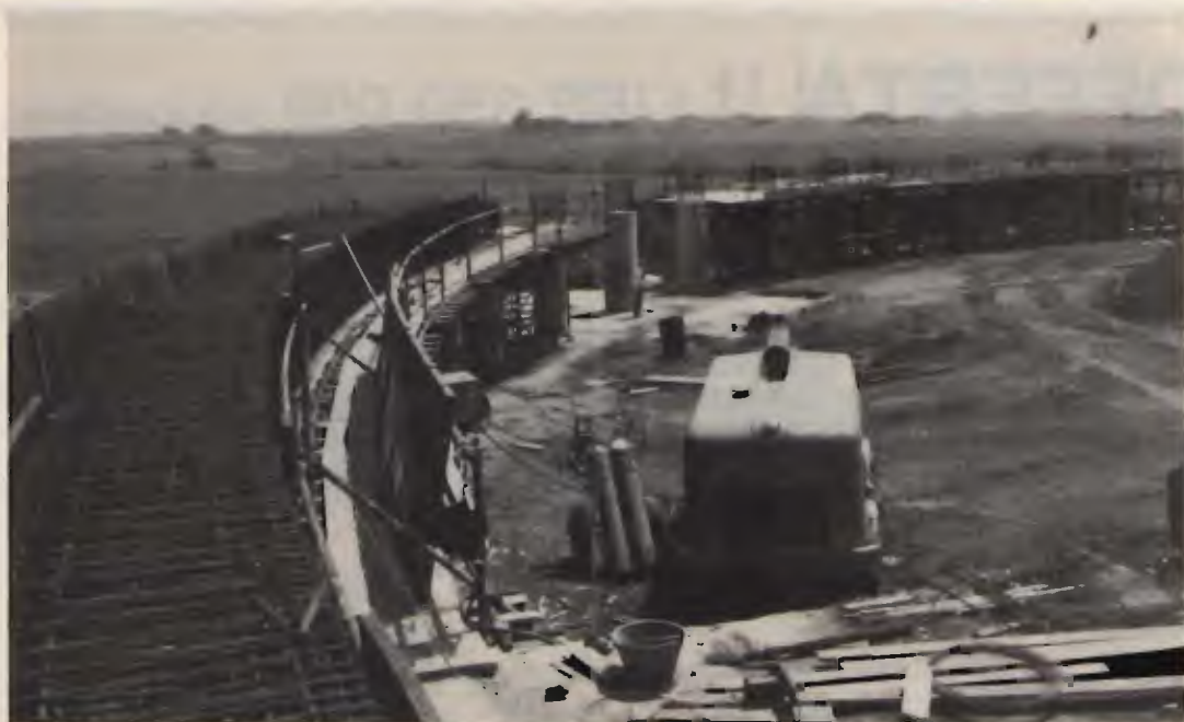
figura 8 A S.M. di Galeria si lavora alla costruzione della rotaia di cemento per l'antenna rotante di nuova concezione.
