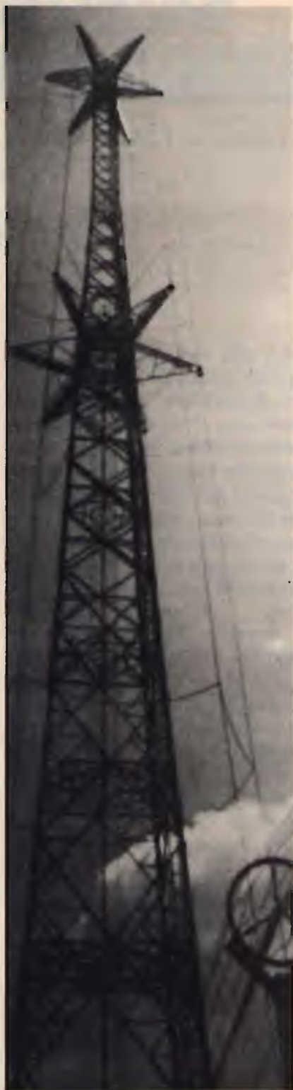
figura 2 Una delle torri con i caratteristici elementi radianti a stella.
