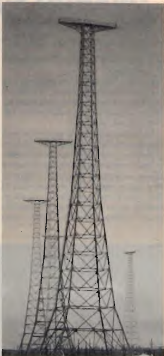
Tralicci delle antenne di Radio Giappone a Yamata. Le stazioni trasmittenti giapponesi vengono gestite dall'Ente per le telecomunicazioni "KOD". In attesa di utilizzare una nuova stazione da 500 kW in patria, R. Giappone ha noleggiato la stazione gabonese di Moyabi da cui irradia con ottimo segnale la propagazione per l'Europa.
