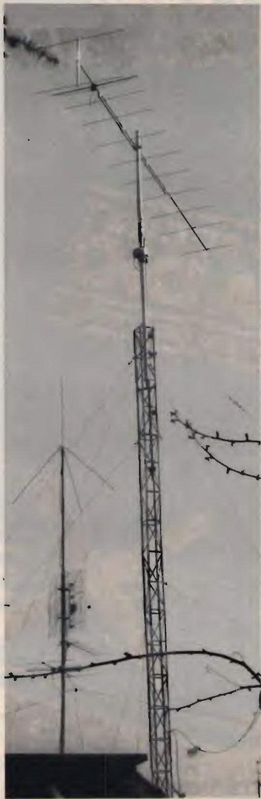
Il traliccio completo sul terrazzo. Notare i molti tiranti che ne assicurano la stabilità. Tutto è a posto: si comincia a trasmettere!
