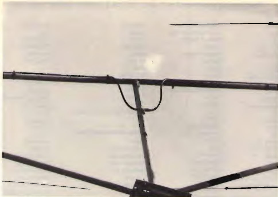
L'incontro dei due spezzoni di cavo RG11 con il bocchettone a T per la discesa.
