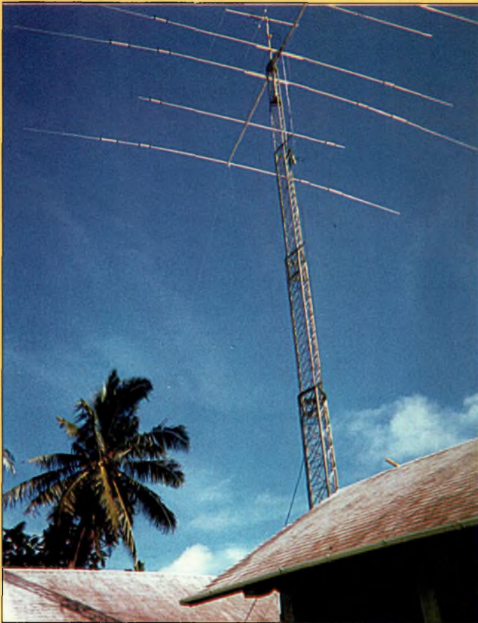
Système d'antenne à KH8/N5OLS, où Jon opérera. Remarquez la beam 6 mètres à 3 éléments au sommet de la tour que Jon a amenée avec lui et qu'il a installée.
