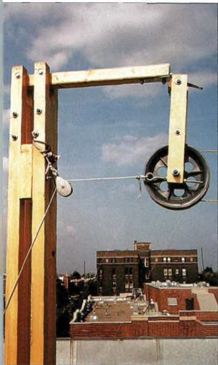
Photo 4 – La poulie commandée à l'extrémité est montée sur un bras mobile. Cela permet de tendre l'antenne et de fournir un contrepoids pour lever le mou.
