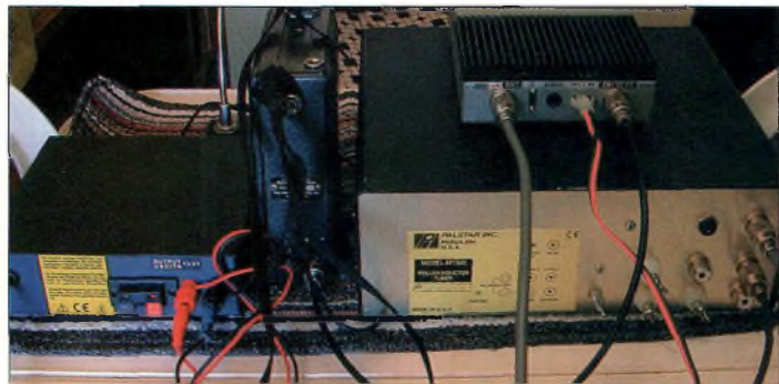
Les raccordements à faire du côté de la connectique.
