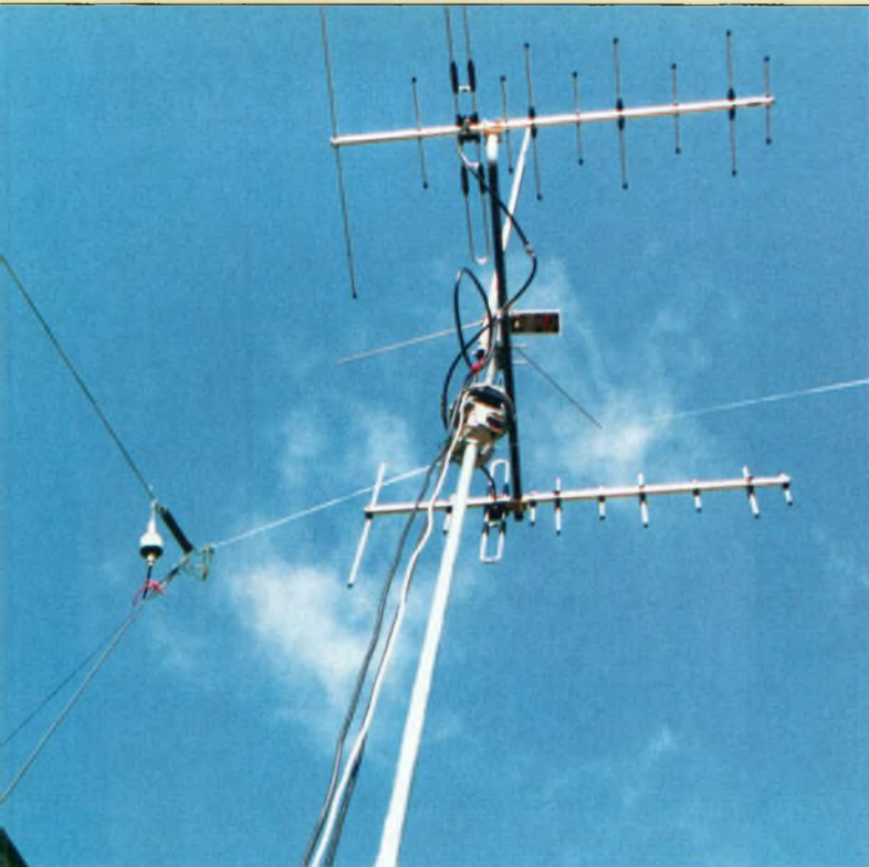
Mise en œuvre d'une Conrad Windom avec son transformateur en haut.
