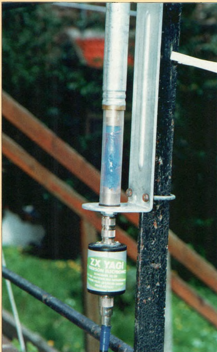
Un autre exemple de liaison qui met en œuvre un adaptateur de genre.
