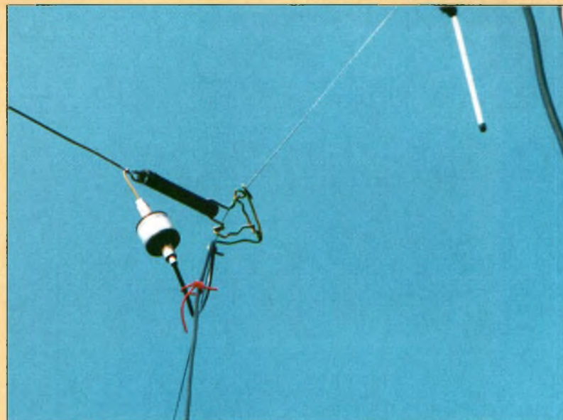
Gros plan sur le transformateur d'impédance placé directement sur une Conrad Windom.
