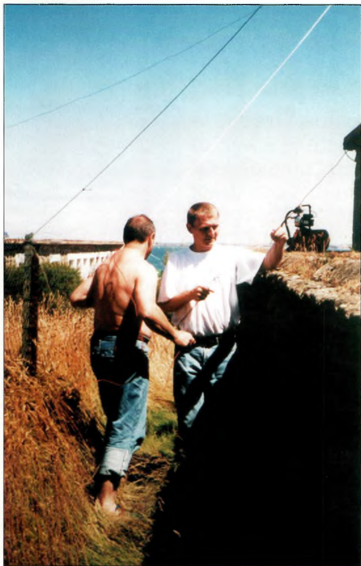
Installation des dipôles.
