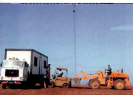
Livraison du container-shack pour les bandes hautes.
