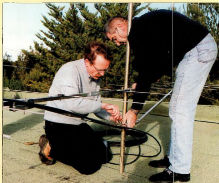
Mise en place des antennes VHF.
