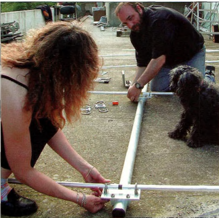
Le montage des éléments se fait assez rapidement.
