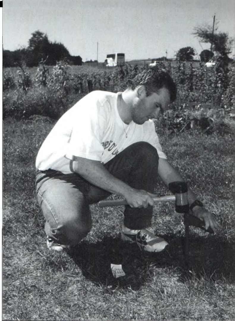
Le marteau (un Facom !) est livré dans la caisse. Ici, Yan, F-11556, enfonce l'un des piquets de haubanage avant le montage de l'antenne.
