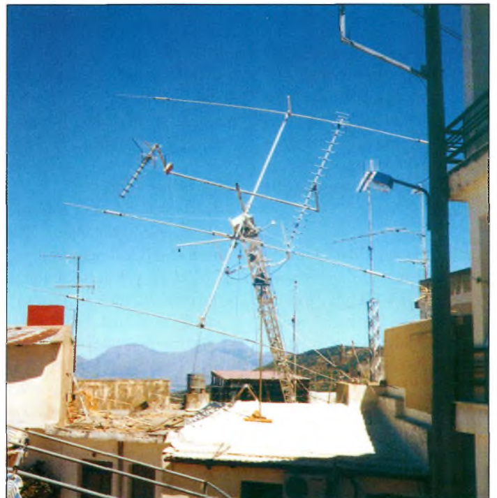
Les antennes chez SV9OG, en position basse pour les protéger du vent.
