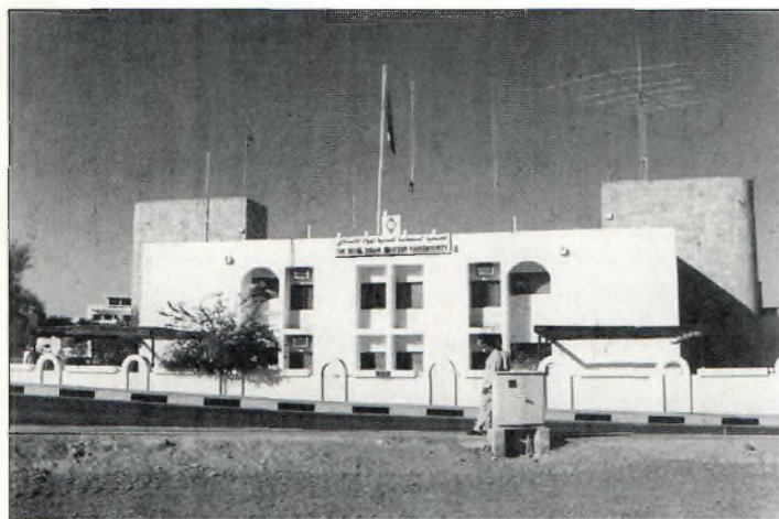
Le local de la Royal Omani Amateur Radio Society, où se situe la station A45ZN.
